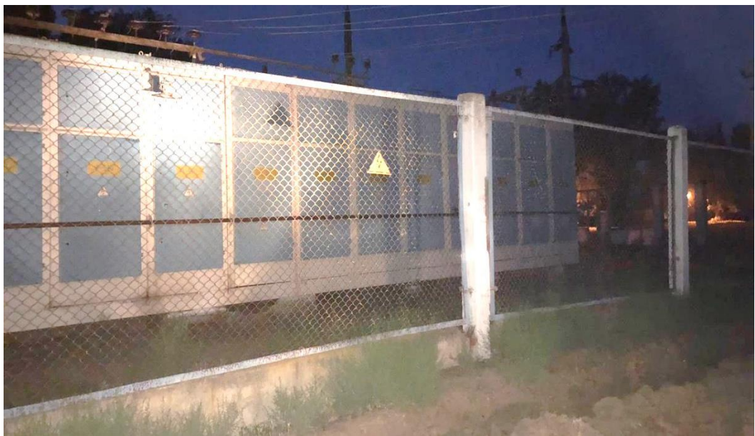
Фотография №1. Общий вид ограждения ПС 35 кВ Новкус Артезиан.
