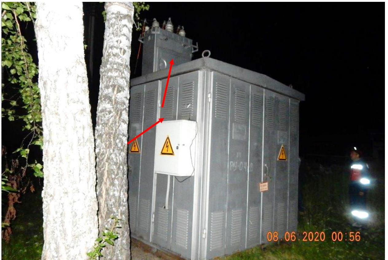
Фотография № 2. Место подъема подростка на крышу трансформаторной подстанции.
