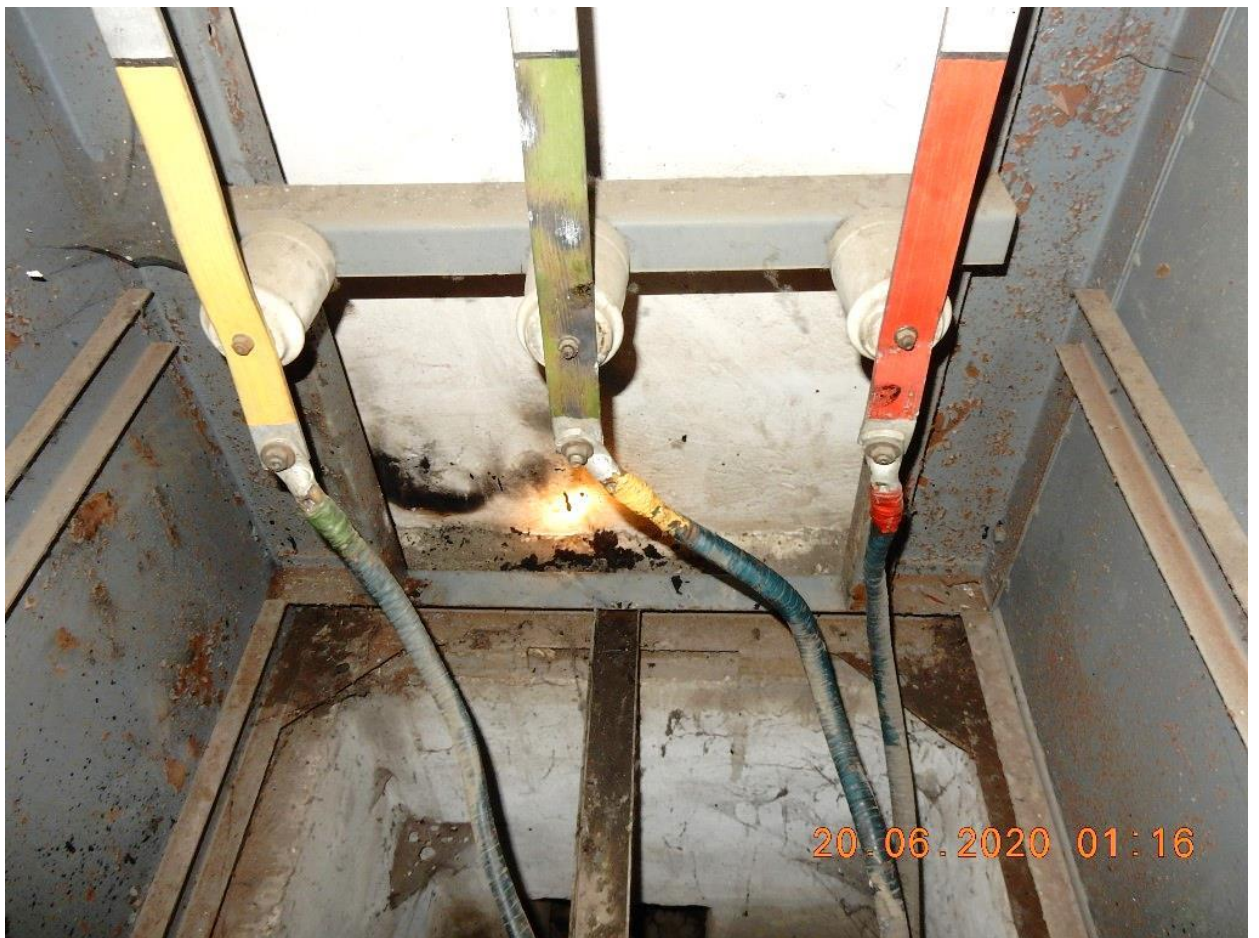
Фотография №5. Следы воздействия электрической дуги и остатки горелой одежды в ячейке.
