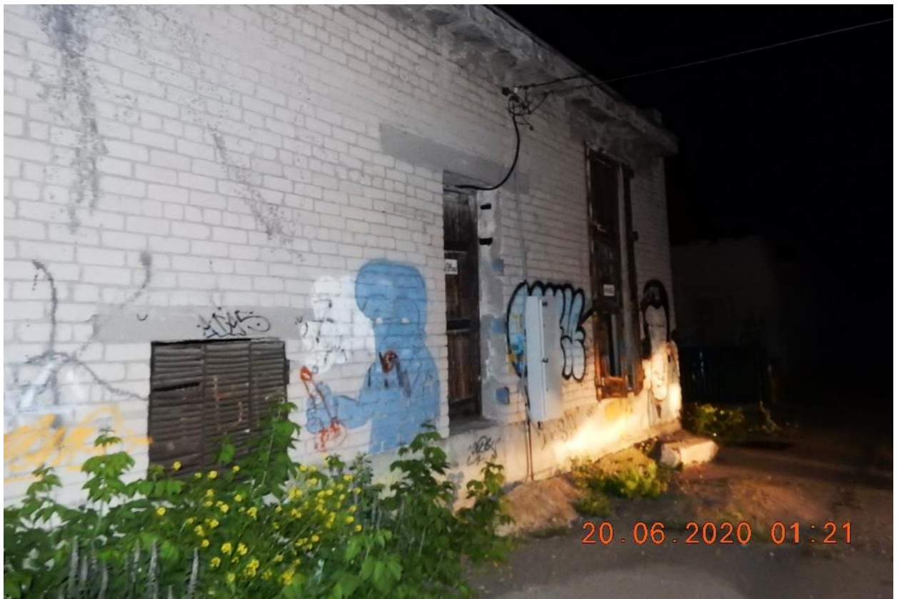
Фотография №1. Общий вид трансформаторной подстанции ТП-42
